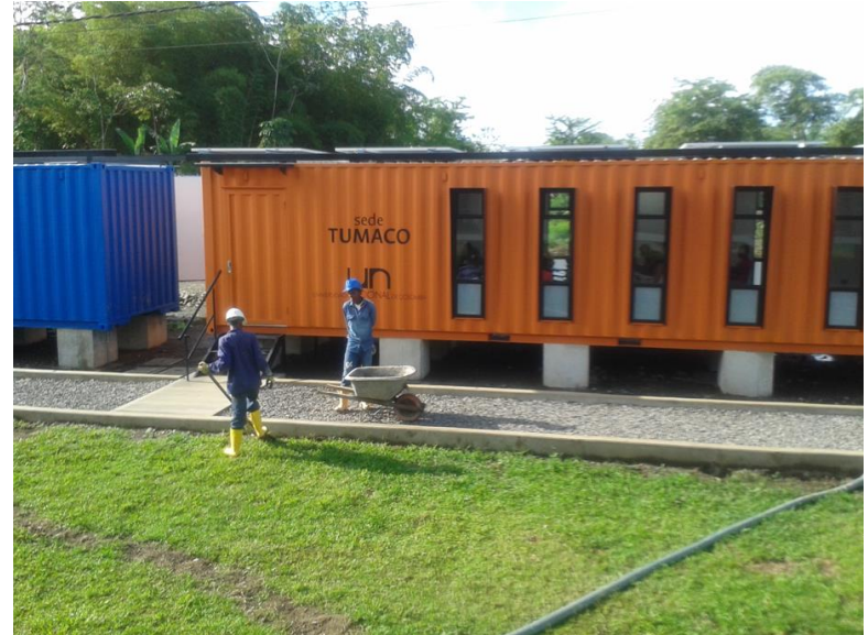
Adecuación de cunetas
