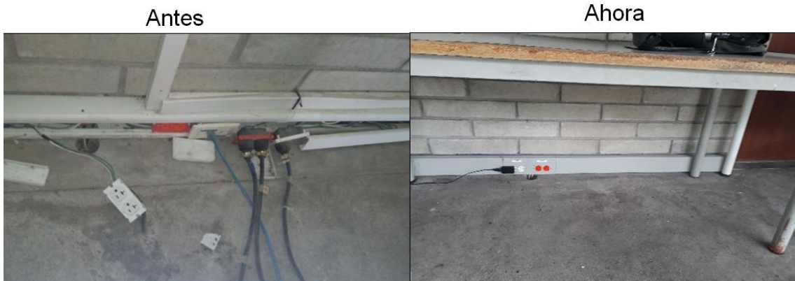
Fotografía 15 Adecuación cableado eléctrico y red datos
