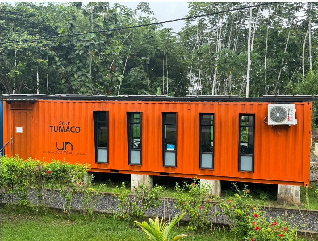
Exterior aula, espacio modular, Sede Tumaco, UNAL
